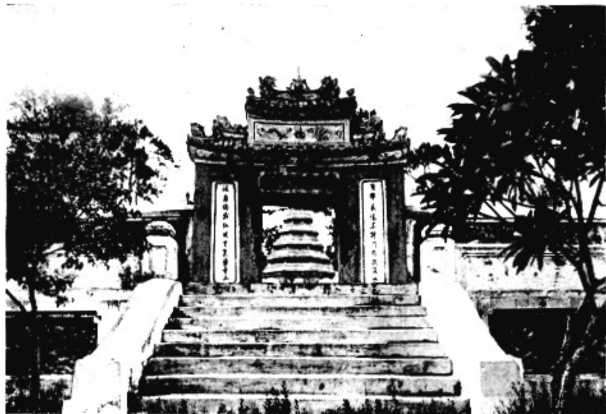
Planche CXLII. — L'escalier et la porte d'entrée.
